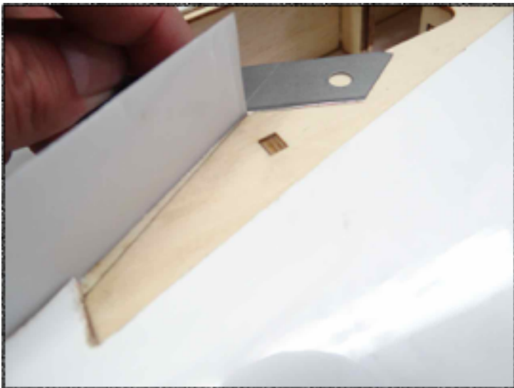
Schneiden sie das überflüssige Material mit einem scharfen Messer ab
