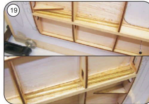
F 23 beidseitig zum Kammholm satt einharzen, Baubrett dazu jeweils bis zum Trocknen senkrecht stellen
